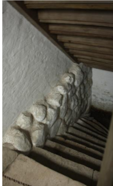
trappenedgang hvor den fuldmuret sokkel er synlig.
